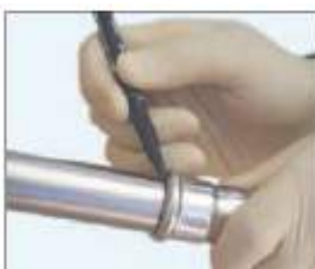
Hacer una marca para posteriormente asegurar el prensado
