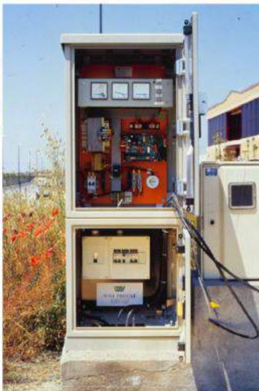
Transfo - rectificador en armario de poliéster de intemperie.
